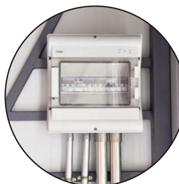
Cuadro eléctrico independiente para alimentación de luminarias, enchufe de ventilación, ventilador y termostato.
