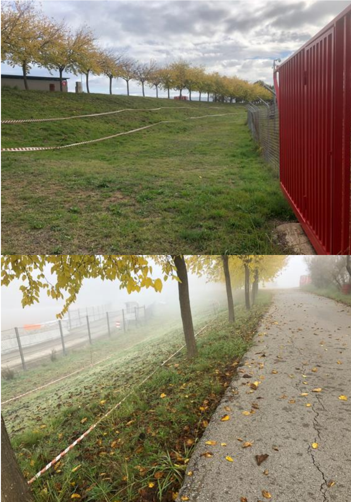
Fotografies del talús existent on cal fer el desmunt de terres per encaixar el desplaçament del vial de servei i construcció de l'estructura de contenció de terres.
